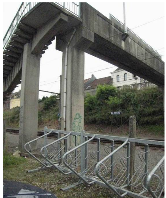
Gare de La Roche
